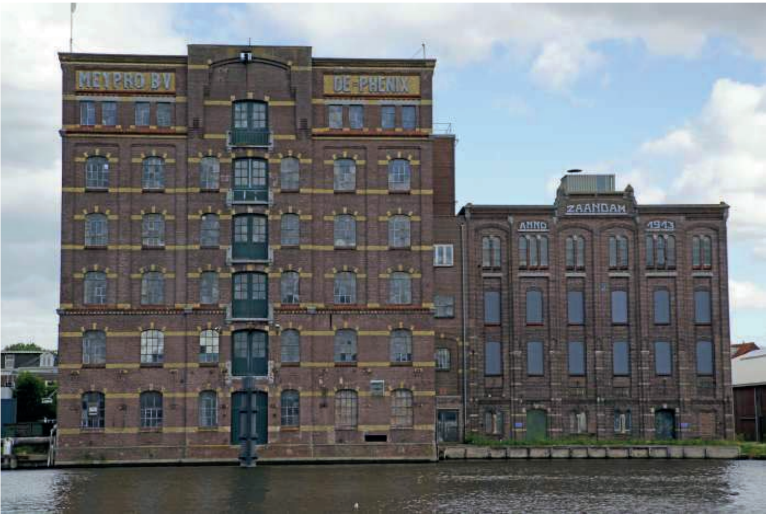
uitwendige techniek/ installaties
