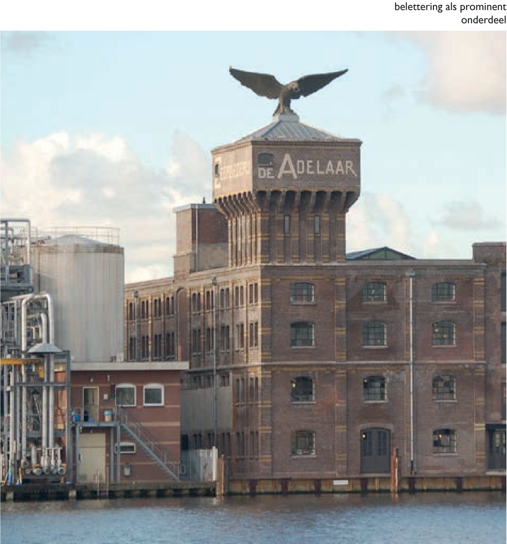
lagen van bebouwing door de tijd goed te zien in de huidige context
