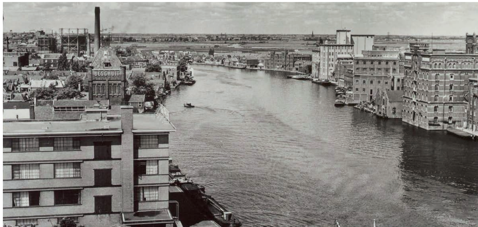
wandvorming met hoge bebouwing aan de oevers zorgt voor stedelijk karakter van Zaandam
